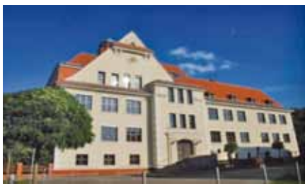
Grundschule »Am Park« Schulstraße 2, 02977 Hoyerswerda
